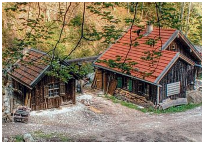
Denkmal: Die Unterammergauer Wetzsteinmühle, AMMERRAUER ALPEN
